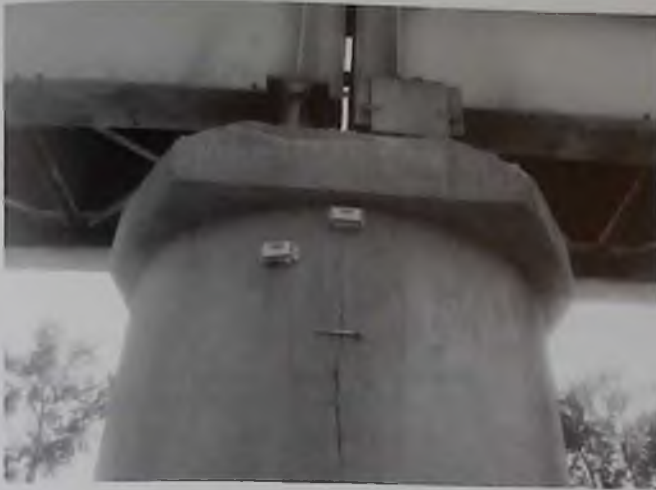
Рис. 2. Установленные измерительные модули на контролируемой опоре эстакады
