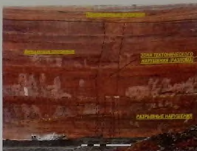
Рис. 4. Положение рудовмещающего разлома в северном борту карьера
