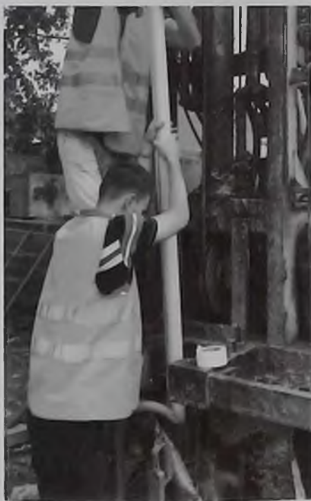
Рис. 3. Установка инклинометрических направляющих в скважину
