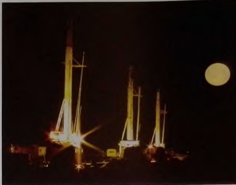
Буровые работы на Далматовском месторождении
